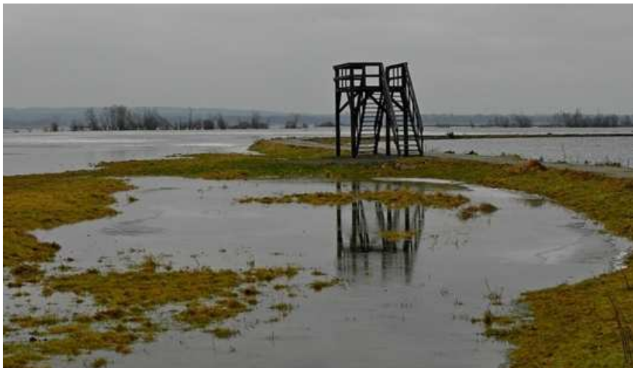
Obecna platforma widokowa przeznaczona do usunięcia
