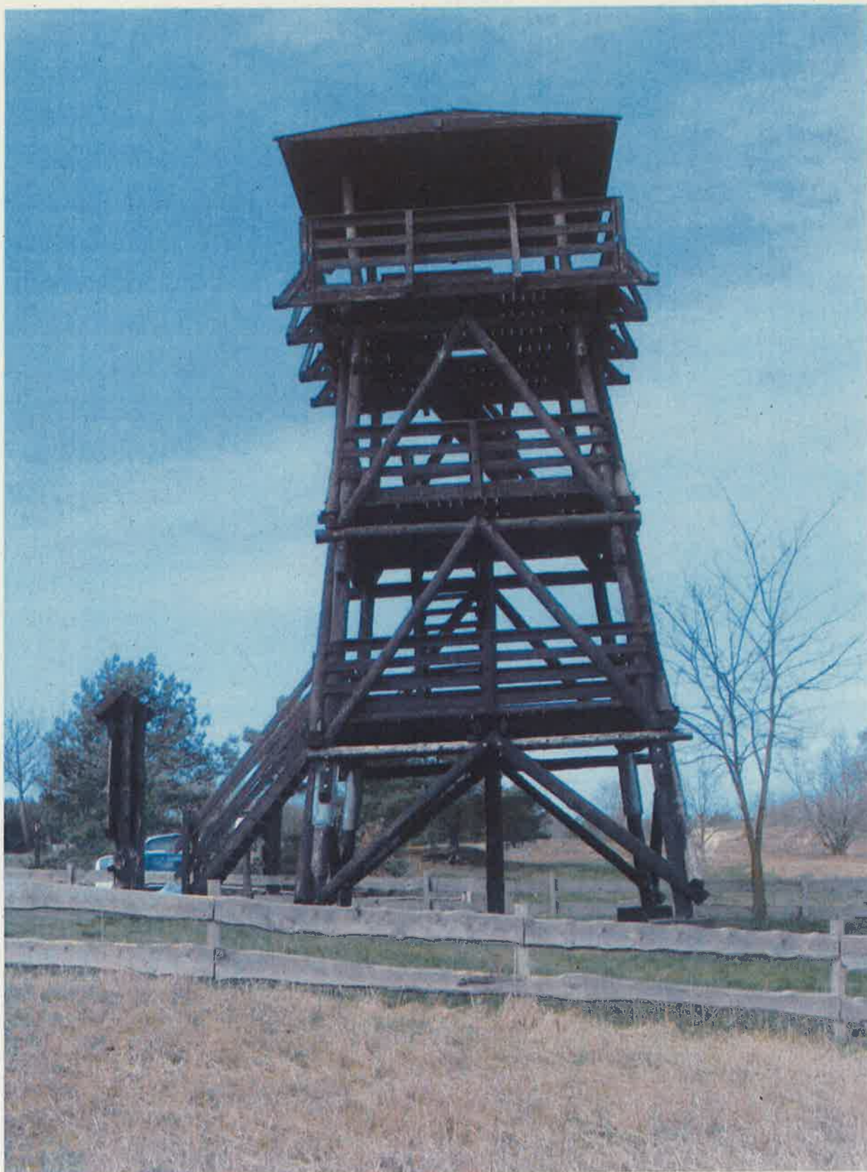
Fot. 2 Widok 2 wieży
