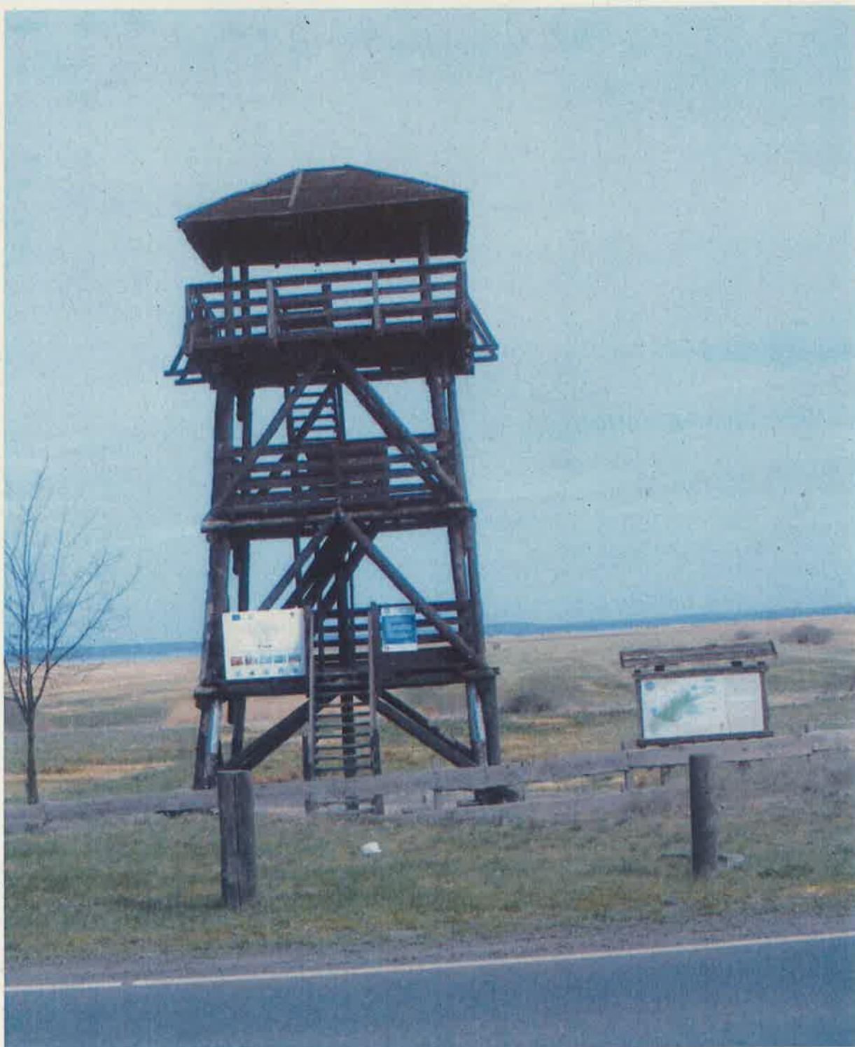
Fot. 1 Widok 1 wieży
