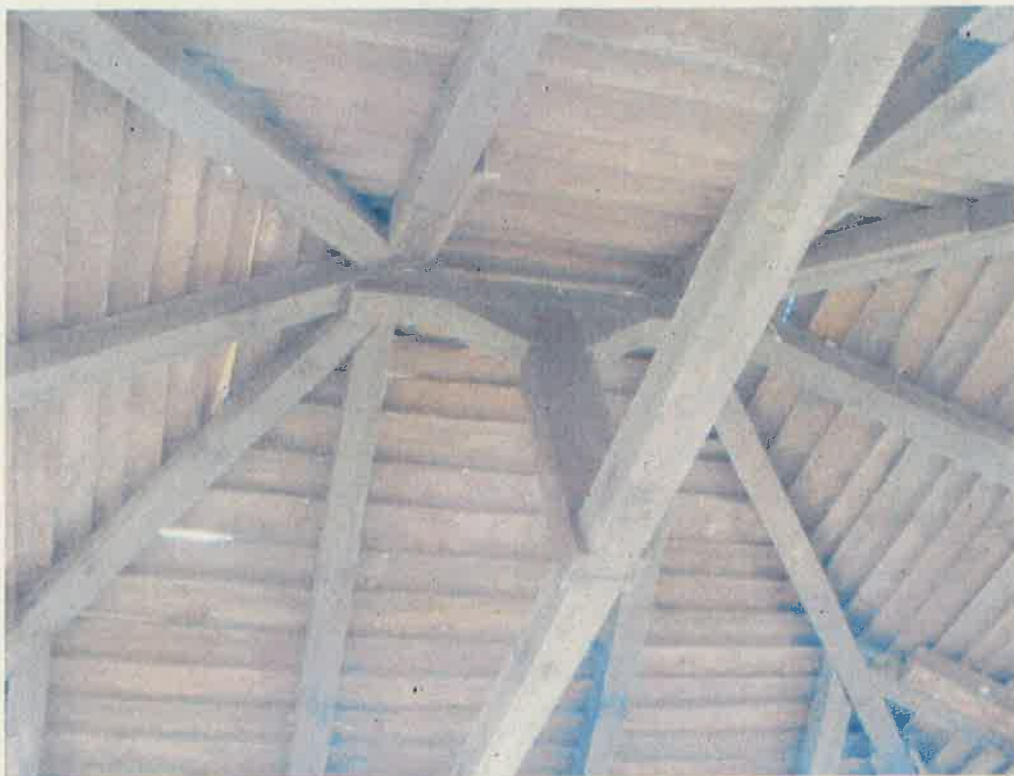
Fot. 5 Widok dachu
