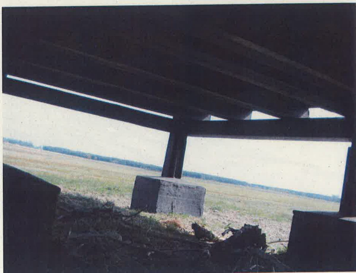
Fot. 3 Widok fundamentów wieży
