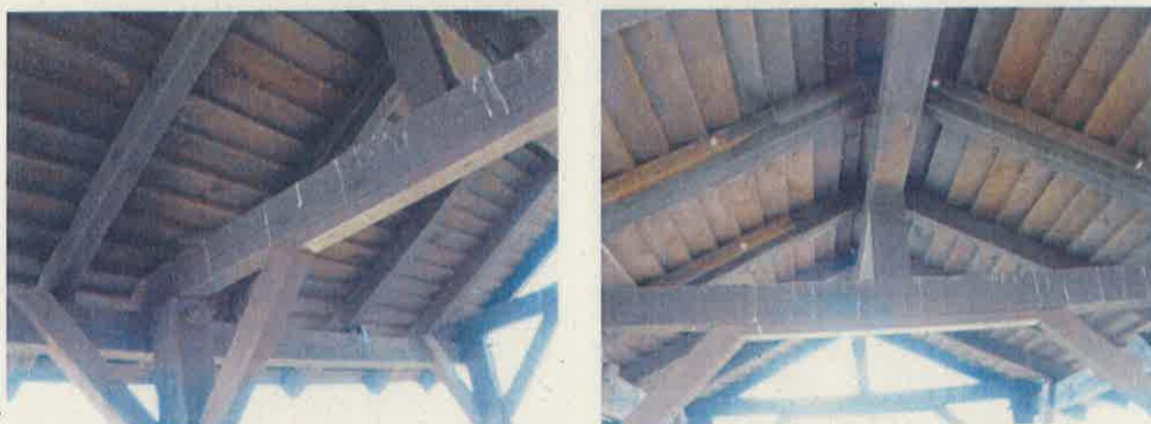
Fot. 5 Widok dachu
